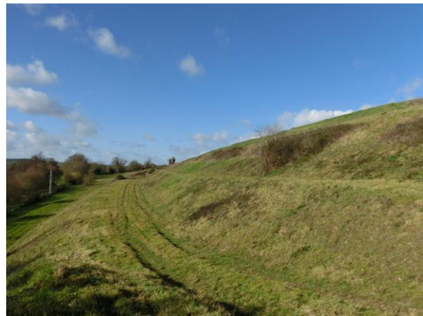
Photographie 9 : Zone réhabilitée - Paliers
