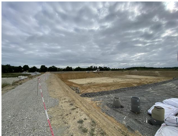
Photographie 8 : Future zone en rehausse
